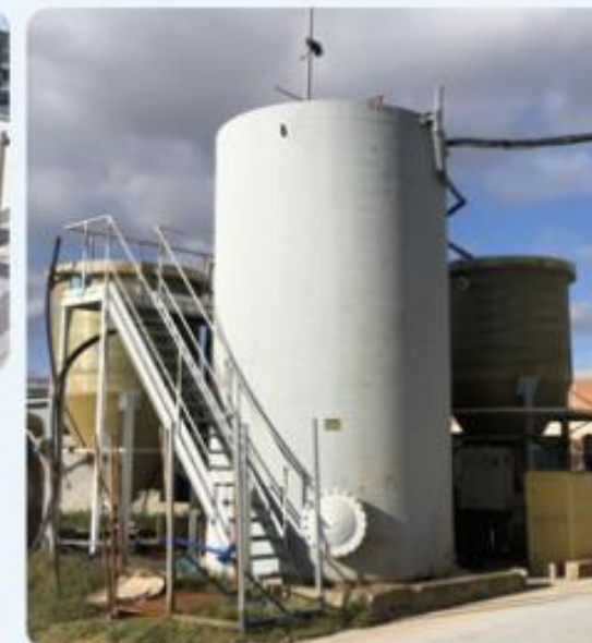
工場排水の浄化システム
