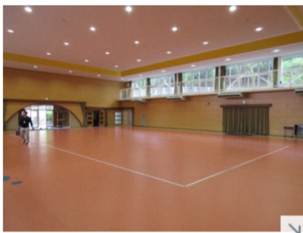
姫路市立書写養護学校の体育館内部。床材には衝撃吸収性に優れた「タラフレックス」が使われている＝兵庫県姫路市書写台3で（姫路市提供）
