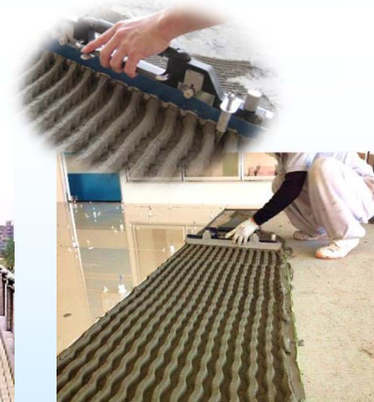
セラミックタイル施工 (ストライピング工法)
